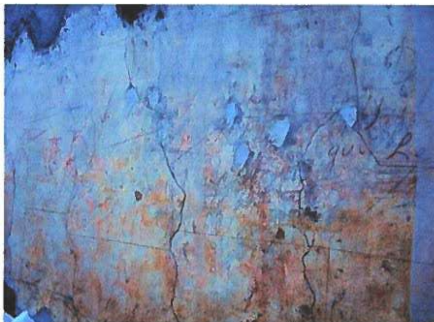
Foto 44: Dibujo de las líneas de corte, numeración y marcas de colocación de las piezas
