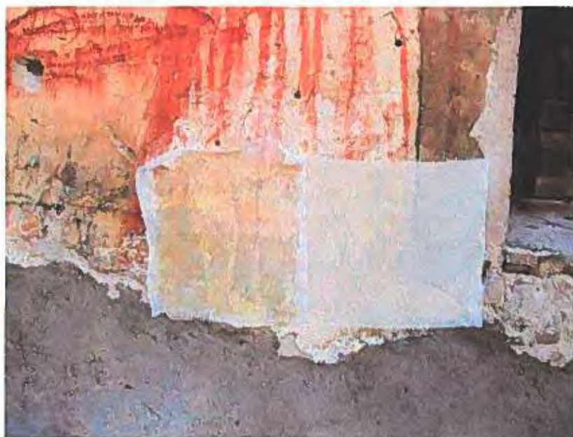
Foto 34: Segunda prueba de arranque realizada en el paño A
