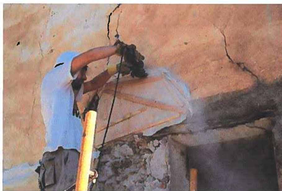
Foto 44: Corte de los bordes de la pieza con amoladora
