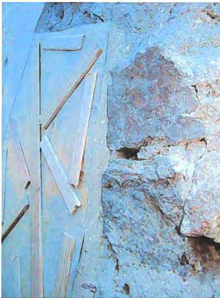
Foto 48: Detalle del perfil del corte. Se observa lo compacto del mortero, y la diferencia de grosor que alcanzaba dependiendo del perfil de la mampostería; en algunos casos de hasta 10 cm de diferencia
