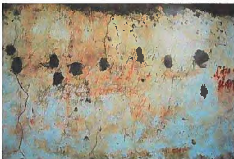
Foto 39: El cemento que se observa en la foto se eliminó y se sustituyó por un mortero de restauración
