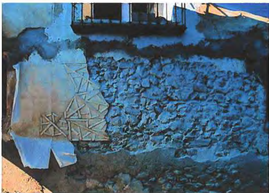
Foto 50: proceso de arranque,
