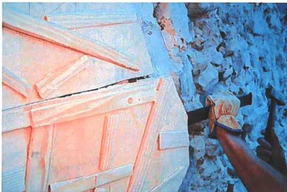
Foto 47: proceso de arranque, separación del mortero de la mampostería mediante herramientas metálicas
