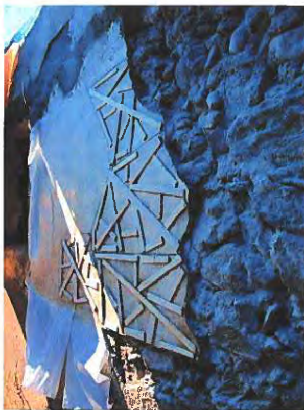
Foto 51: proceso de arranque, perfil. Se puede observar el corte aprovechando una grieta profunda. También se puede ver el tipo de mampostería tan irregular
