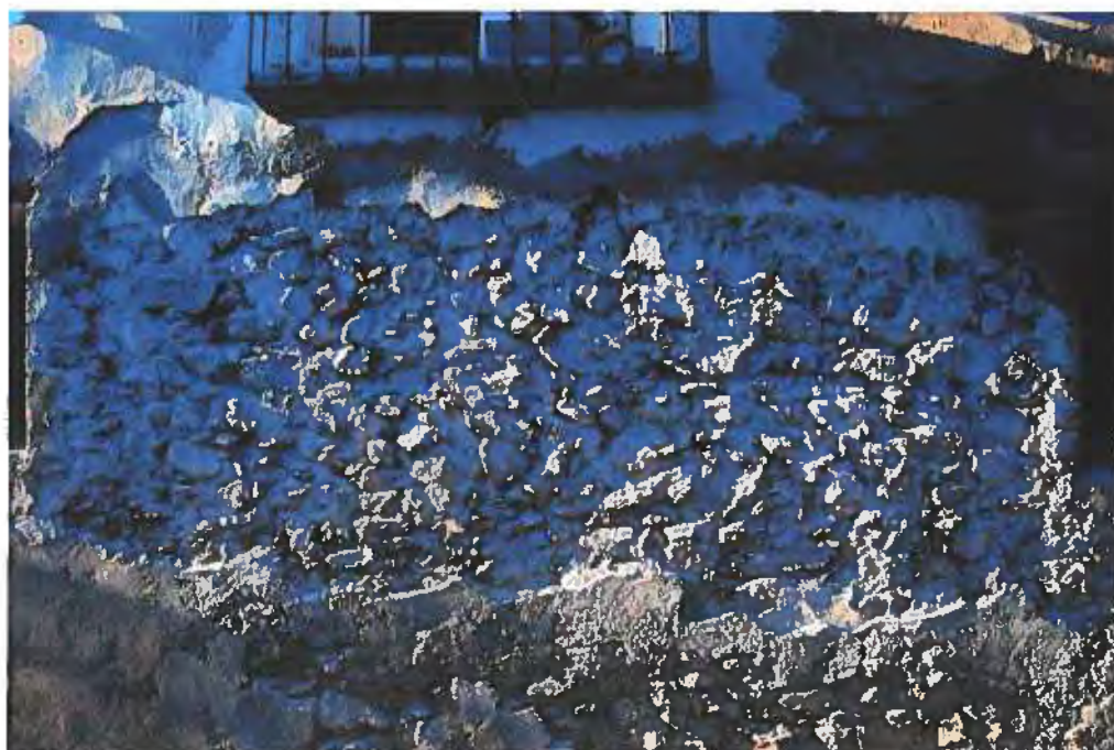
Foto 52: Pafio B una vez realizado el arranque. Con esta luz rasante se observa las irregularidades del muro, las zonas profundas y salientes que complicaron el proceso.
