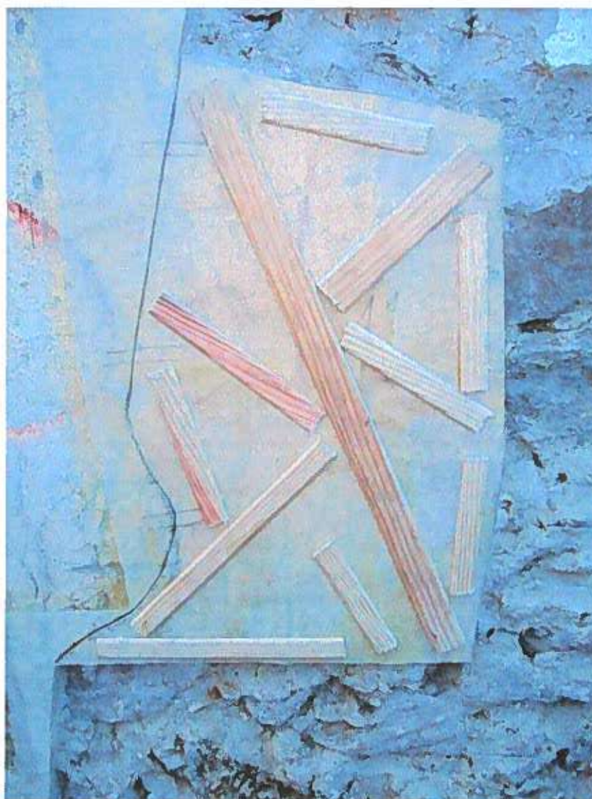
Foto 43: Colocación de los listones de refuerzo sobre la tela, antes de proceder al arranque de la pieza
