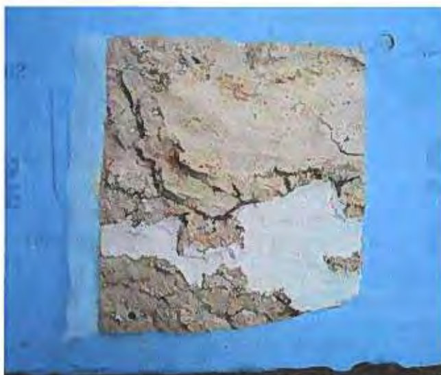
Foto 54: Tratamientos en el reverso. Eliminación de picos de mortero, limpieza y relleno de faltas con mortero de restauración
