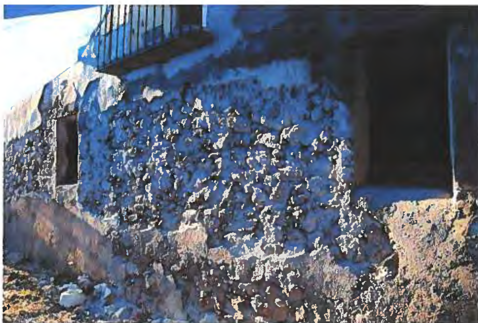
Foto 53: Paño B una vez realizado el arranque. Con esta luz rasante se observa las irregularidades del muro, las zonas profundas y salientes.
