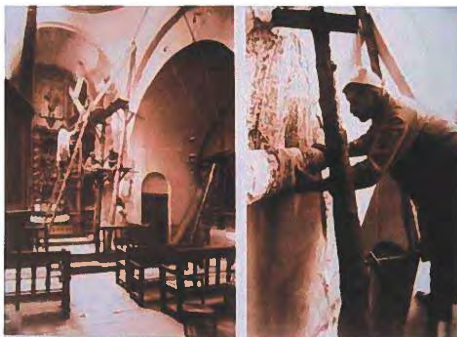
Foto 27: Los arranques de pinturas murales se realizaban en un principio con la técnica de strappo, por maestros italianos. En esta foto se puede ver al Maestro Stefanoni arrancando una pintura en Santa María de Taüll en 1919
