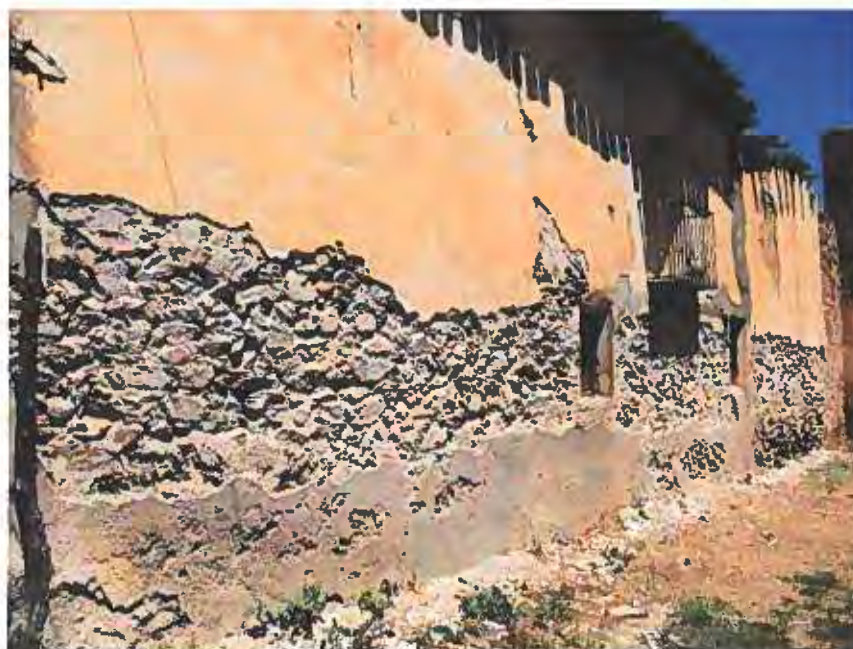
Foto 38: Vista general de la fachada tras el arranque
