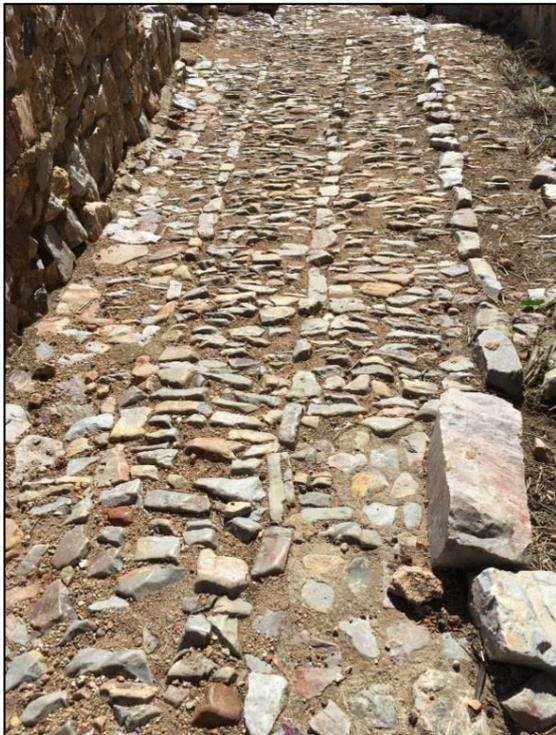
Figura 45. Pavimento empedrado con carriles longitudinales en el interior del recinto fortificado de Calatrava la Nueva.
