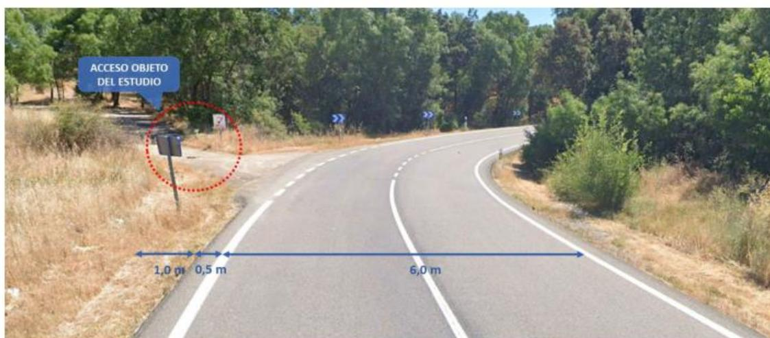
*Imagen 8 – Sección transversal del tramo de estudio de la carretera M-137.*
