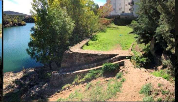
ESTADO ACTUAL DE LOS FILTROS
