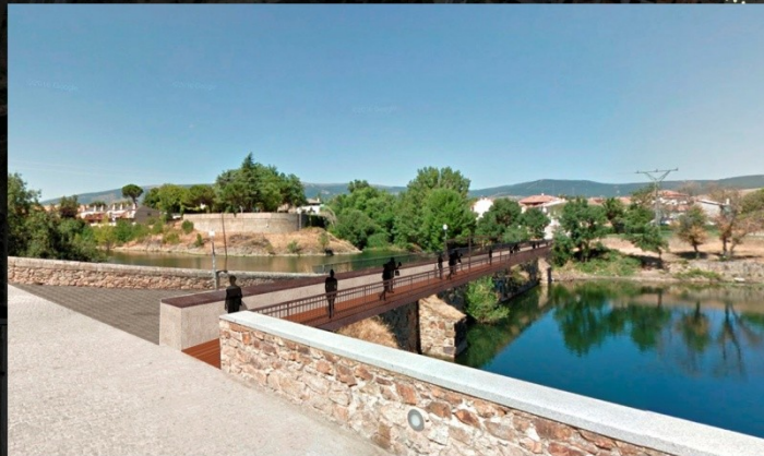
VISTA PASARELA DESDE LA CALLE PILONCILLO
