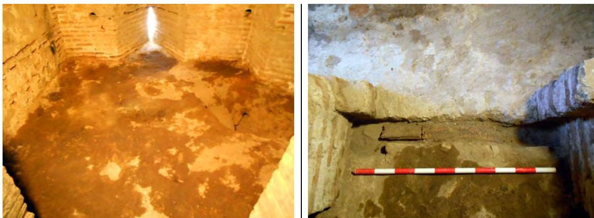
El suelo de todas las estancias se ha cubierto con una tela geotextil sobre la que se ha extendido una capa de grava.
