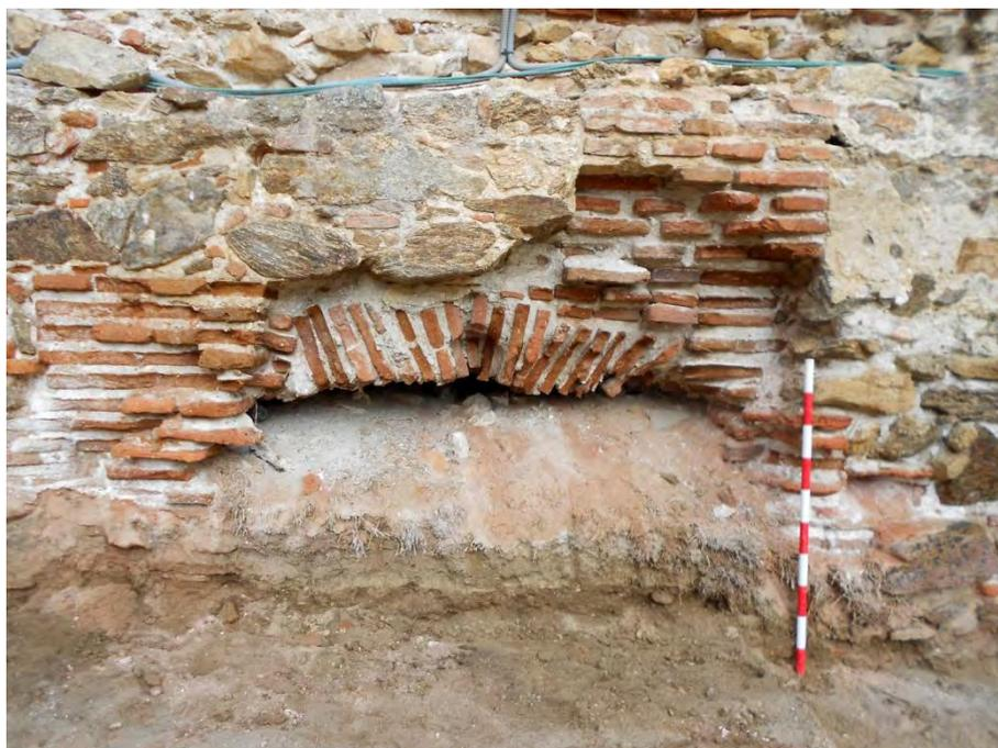
Colmatado por un relleno de tierra suelta y piedras con restos de ladrillo y tejas, ha salido a la luz un portillo que atraviesa este lienzo de muro delimitado por dos muros laterales de ladrillo, con un paso formado por un arco de medio punto también de ladrillo situado al fondo.
