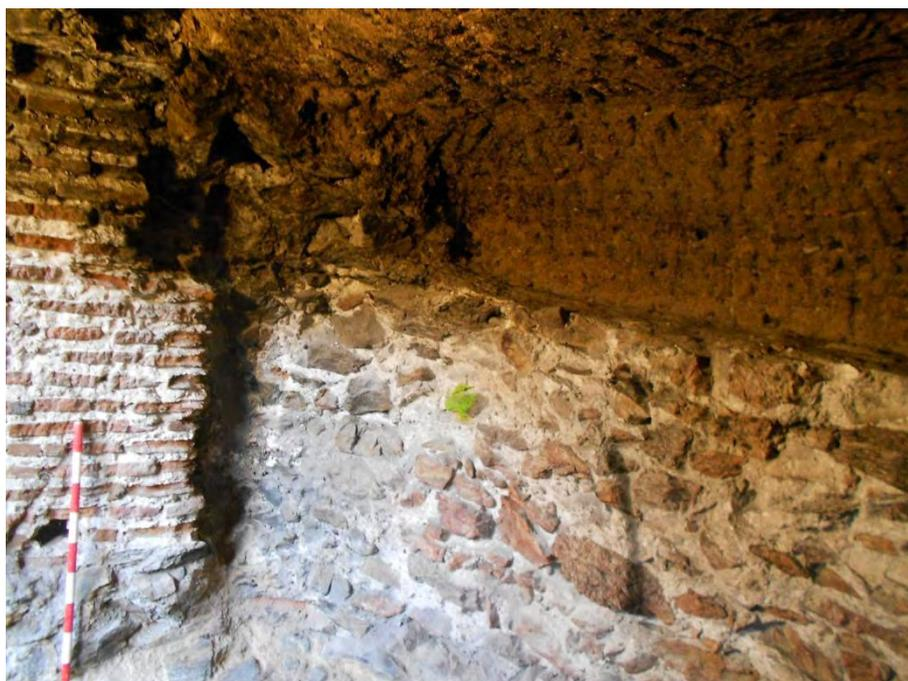
Este hueco en la base de la torre nos ha permitido conocer interiormente la forma constructiva de la misma. El envolvente de cal y canto, el núcleo de tapia, con un cimient base de cal y canto con una fuerte argamasa, donde las cadenas de ladrillo presentan dientes hacia la fachada, pero también hacia el interior del corazón de la obra.
