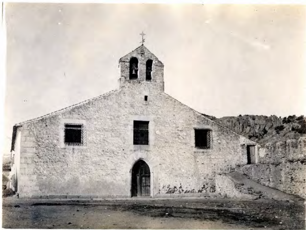
Fachada del Hospital de San Salvador. Primer cuarto del siglo XX.
